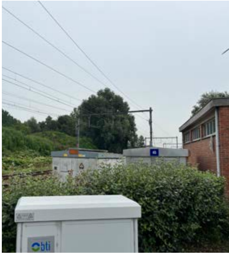
Stukje infrabel naast spoorweg met 3 technische hokken - Rector de Ramstraat
