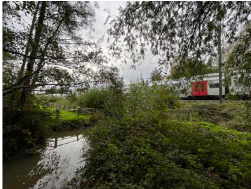
Doorgang Nijlense beek onder spoorweg
