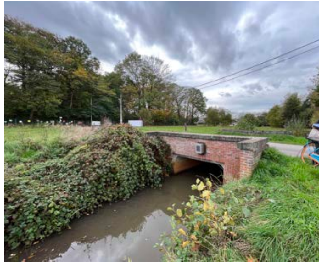
Brug over de Nijlense beek - Hellevoorstraat
