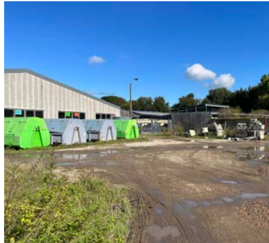
Achterkant Githo (zicht op blok D en fietsenstalling) + grondopslagplaats gemeente
