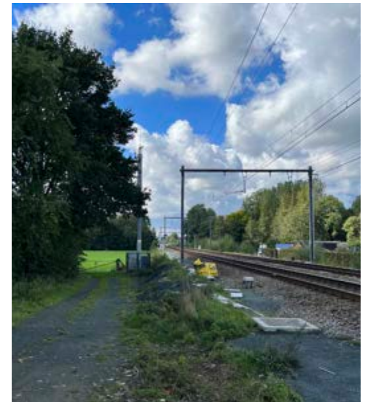
Spooroverweg (Hellevoortstraat) en toegang tot achterliggende privé weilanden
