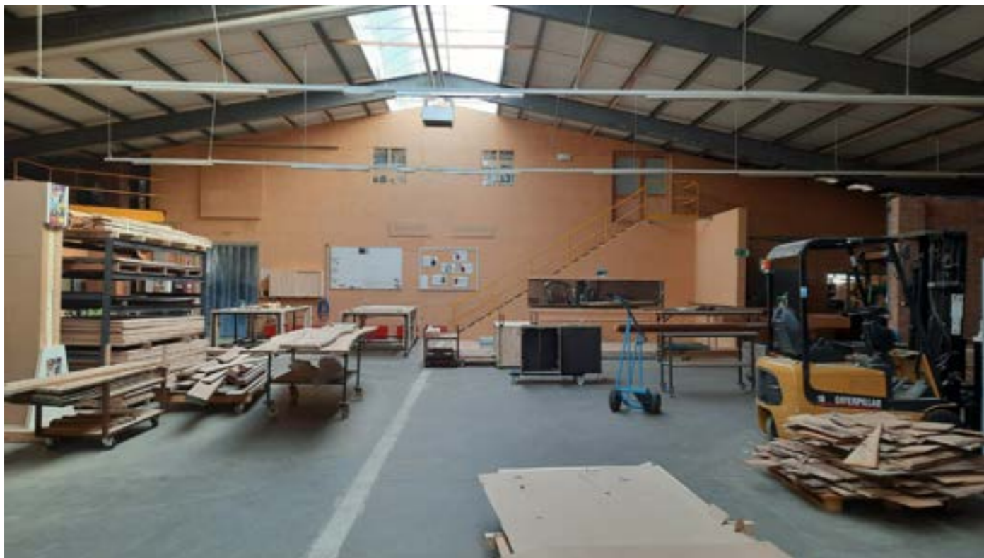
De grote hal heeft een eenvoudige structuur met grote stalen portieken die voor een dubbelhoge kolomvrije ruimte zorgen. De ruimte is enkel zenitaal verlicht door een lichtstraat.
