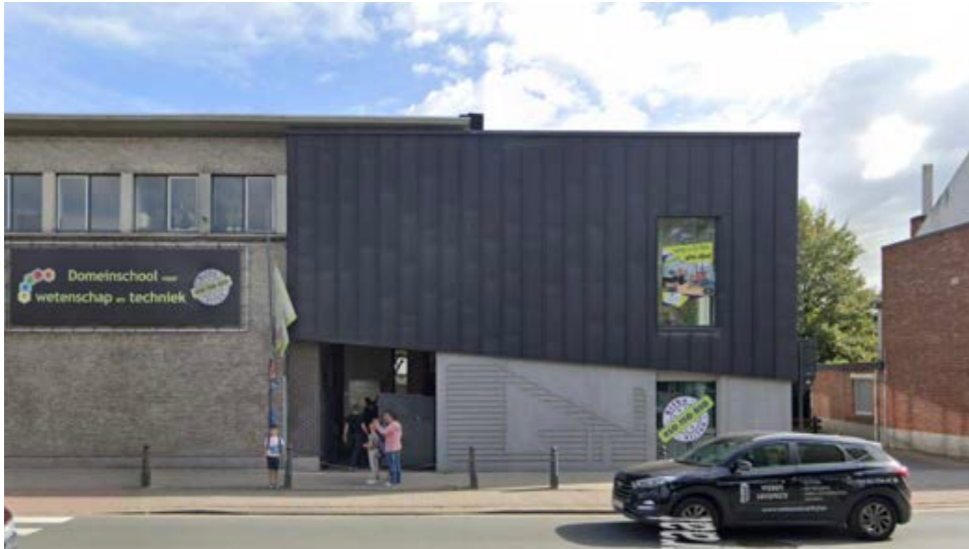
De voorgevel van blok A langs de Gemeentestraat is vrij gesloten en de ingang zit eerder verstopt. Het was de bedoeling het onthaal te organiseren in blok A, maar aangezien er weinig overzicht is op deze plek, is het onthaal op de oude plek gebleven.
