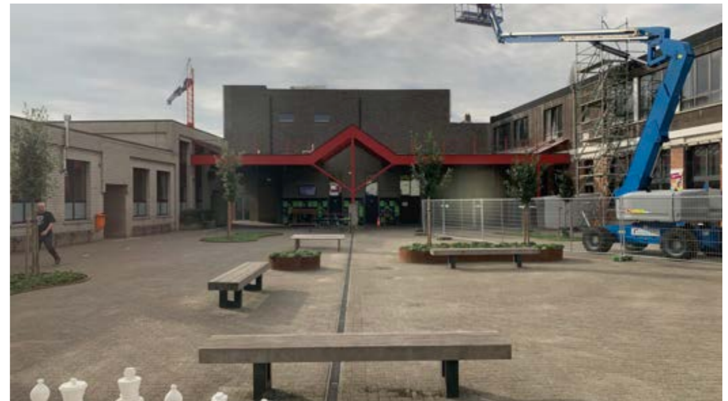
De speelplaats kijkt uit op de gesloten gevel van blok A met de luifel waaronder het sanitair en de lockers georganiseerd zijn.
