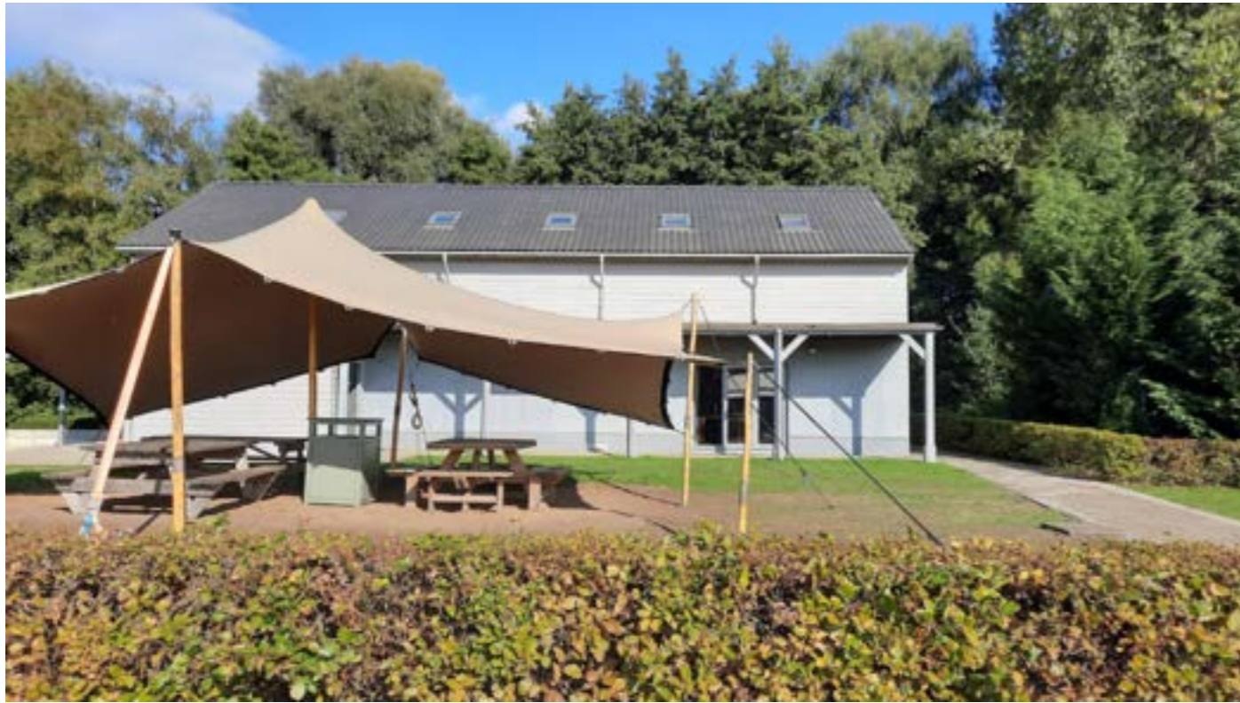
Het houten huis is een voormalig project van leerlingen van het githo. Het gebouw is gelegen vlak naast de Nijlense beek.
