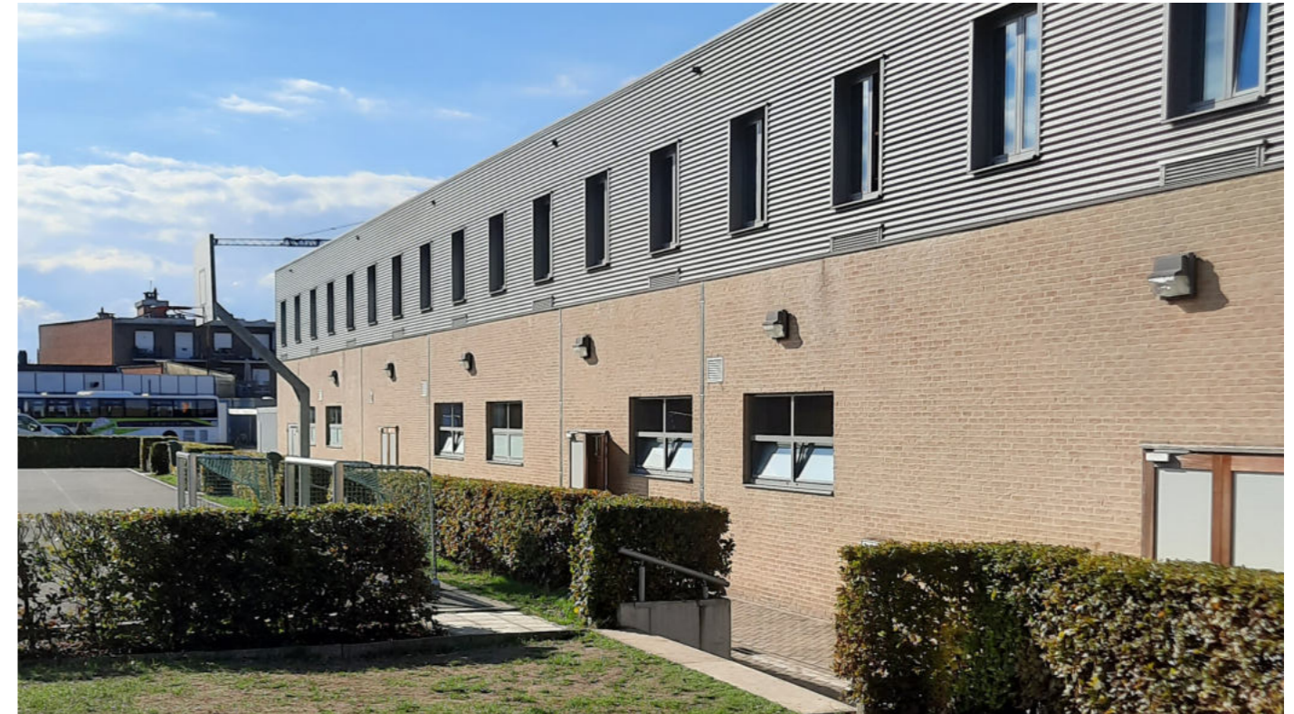
De gevel, die uitgeeft op de speelplaats, is ter hoogte van de werkplaatsen op het gelijkvloers vrij gesloten. Ook hier is de uitstraling van het gebouw niet representatief als gezicht van de school.
