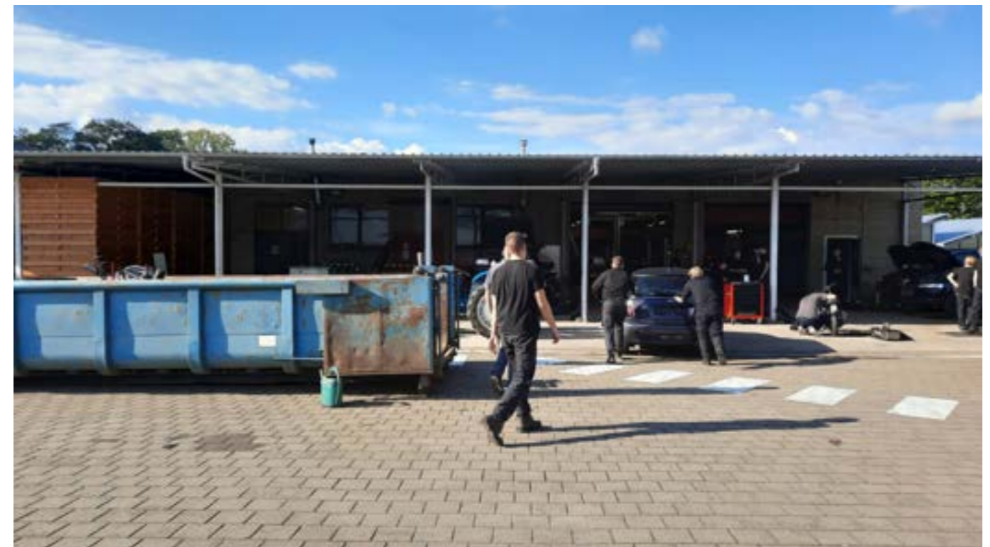
De luifel langs de werkplaatsen vormt een overdekte toegang, maar doet tegelijkertijd zelf dienst als buitenwerkplaats.
