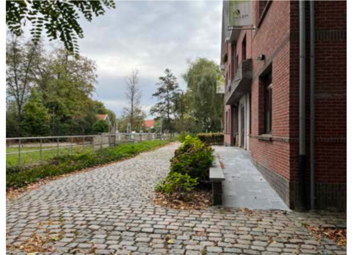
Voorgevel met zicht op 't Hofke en zijgevel met brandtrap (net buiten beeld)
