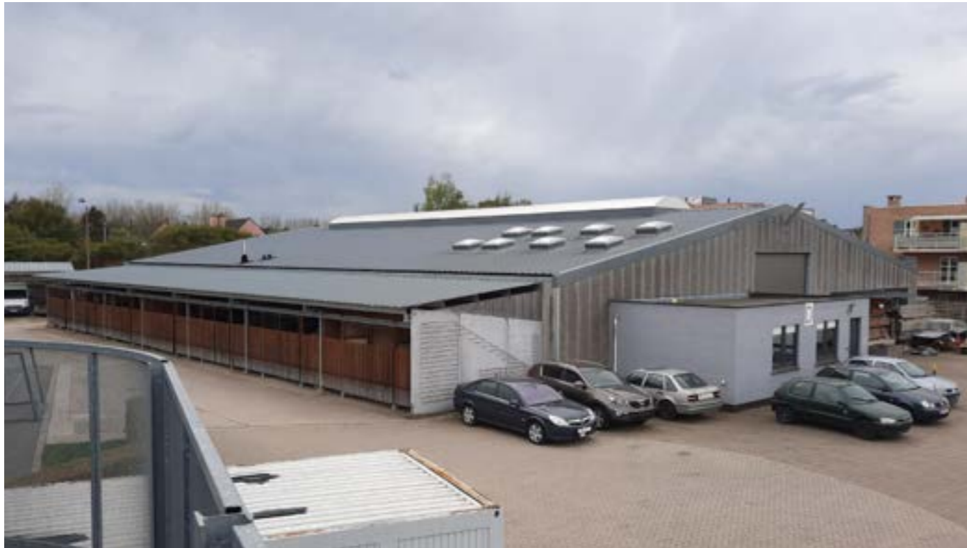
Blok D is de voormalige gemeentelijke werkplaats en wordt gebruikt door de school als houtwerkplaats. Ondanks de grote oppervlakte werd er nog bijgebouwd. Langs de kant van de speelplaats werd een langse luifel voorzien met stockageruimte. Langs de toegang op de kopse zijde is een bijgebouw voorzien en een beetje verder staan er nog containers.
