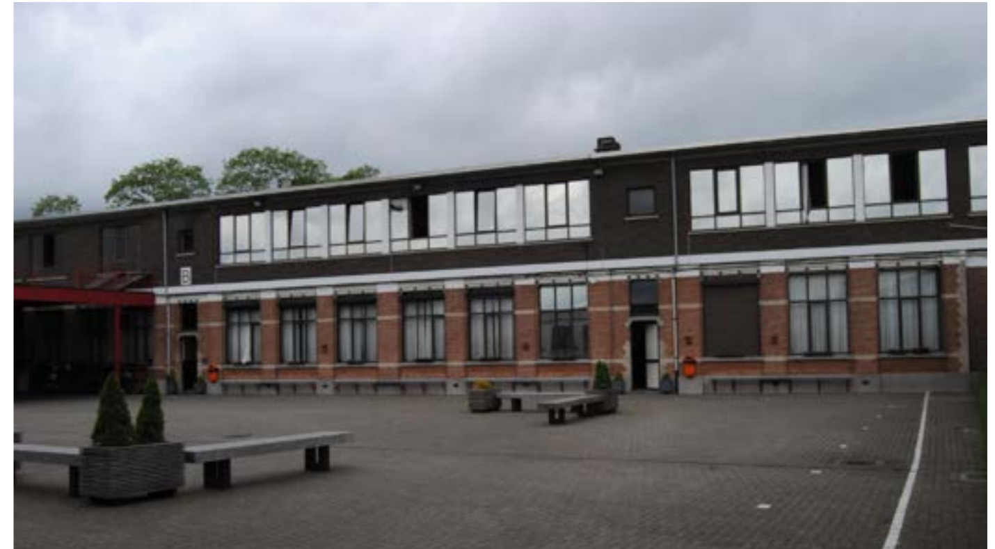
Aan de gevel van blok B langs de speelplaats zie je dat het historische gebouw werd uitgebreid met een verdieping voor extra klassen.
