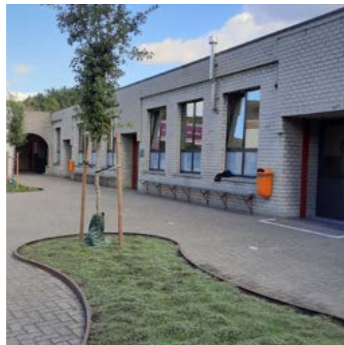
Langs de beek aan de refter en op de speelplaats van de eerste graad zijn er enkele zeldzame groene plekken.
