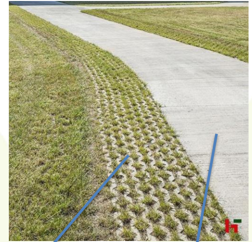
Grasbetontegel + beton
