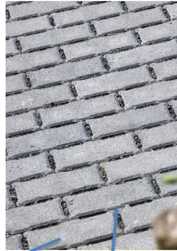
Waterd. betonstr.
