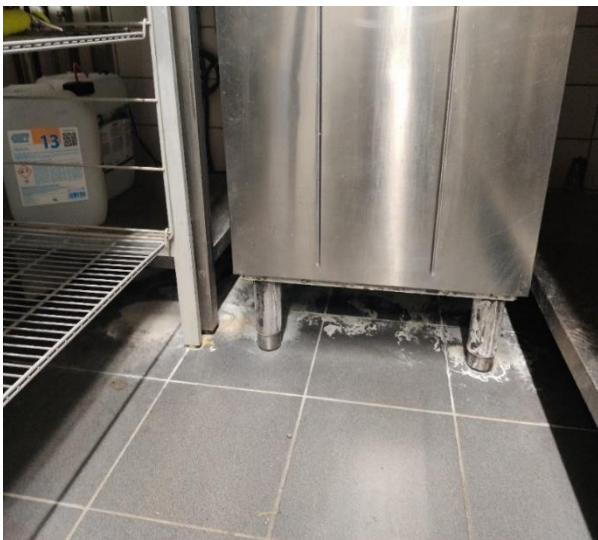
10 (witte aanslag onder afwasmachine)
