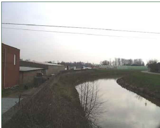
Foto genomen vanop de ijzeren brug over de Kleine Nete, in oostelijke richting
